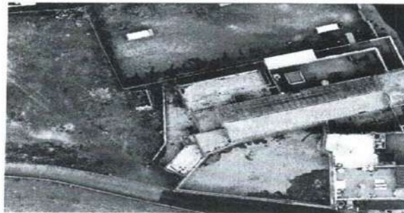
Imagen 5 - Deslinde de propiedades realizado entre topógrafos de partes (aportado por el interesado).
